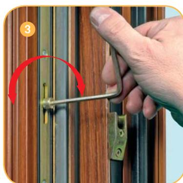
Regulación de la presión de los bulones ( $\pm 1$  mm) con la llave allen de 4 mm.
