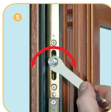
Regulación de la presión ( $\pm 1$  mm) de los bulones fungiformes con la llave fija de 11 mm.
