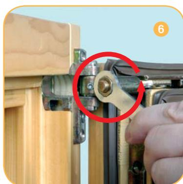
Regulación horizontal del compás  $\varnothing 34$  con llave hexagonal de 13 mm (4 mm de tiro para aire 4 y 7,5 mm para aire 12).
