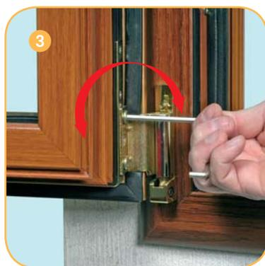
Regulación en presión de la bisagra inferior ( $\pm 1,5$  mm para TESI) con llave allen de 4 mm.
