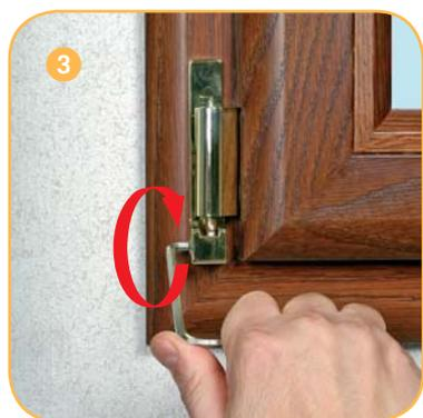
Regulación horizontal de la bisagra inferior ( $\pm 2$  mm para TESI) con llave allen de 4 mm.
