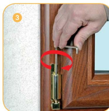
Regulación vertical de la bisagra inferior (de -2 a +3 mm para TESI) con llave allen de 4 mm.
