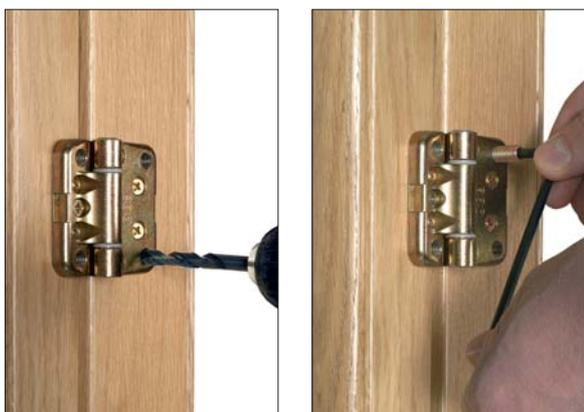
La cerniera autodima guida la foratura del legno per l'applicazione di 4 robuste spine di portata autofilettanti a legno.
