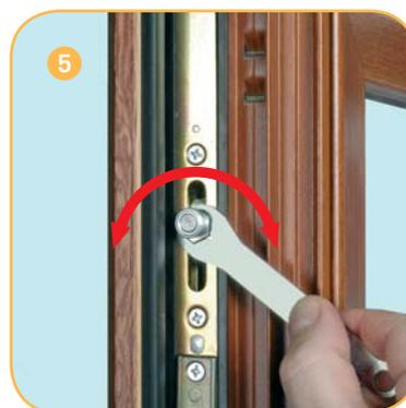
Regolazione in pressione ( $\pm 1$  mm) del nottolino a fungo con chiave fissa da 11 mm.
