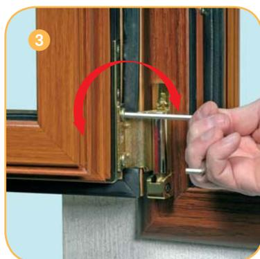
Regolazione in pressione della cerniera inferiore ( $\pm 1,5$  mm per TESI) con chiave a brugola da 4 mm.
