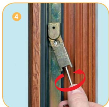
Regolazione del DSS ( $\pm 3$  mm) con chiave a brugola da 2,5 mm.
