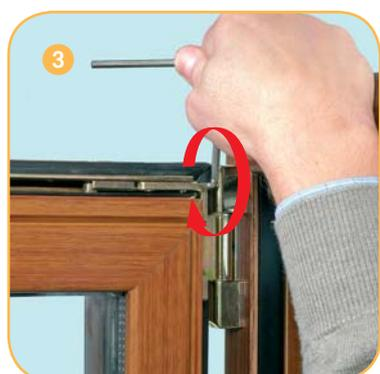
Regolazione orizzontale della forbice TESI - 5 mm a tirare e 2,7 mm a spingere - con chiave a brugola da 4 mm (agevole anche su aperture a 90° utilizzando il lato corto della chiave).
