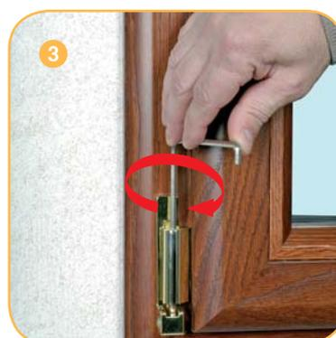
Regolazione verticale della cerniera inferiore (-2 mm verso il basso, +3 mm verso l'alto per TESI) con chiave a brugola da 4 mm.
