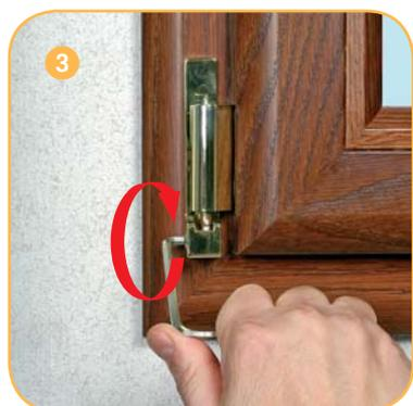
Regolazione orizzontale della cerniera inferiore ( $\pm 2$  mm per TESI) con chiave a brugola da 4 mm.
