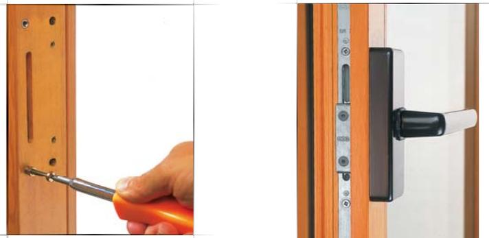
Se il profilo dell'anta è sufficientemente largo, la maniglia si innesta direttamente sul cremone, all'interno del canalino ferramenta. Per profili stretti, un'apposita piastrina guida lama, fornita come accessorio, consente di posizionare la lama di aggancio all'esterno del canalino.
