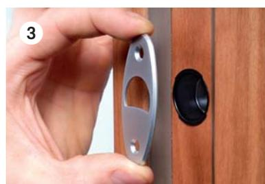
Благодаря специальной форме планки она просто и точно закрывает высверленный диаметр.
