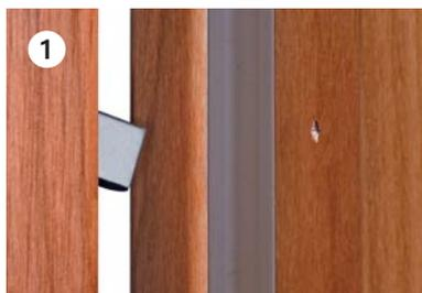
После установки замка и выхода крюка мягкое закрытие двери в косяк даёт возможность отцентровать положение ответной планки.
